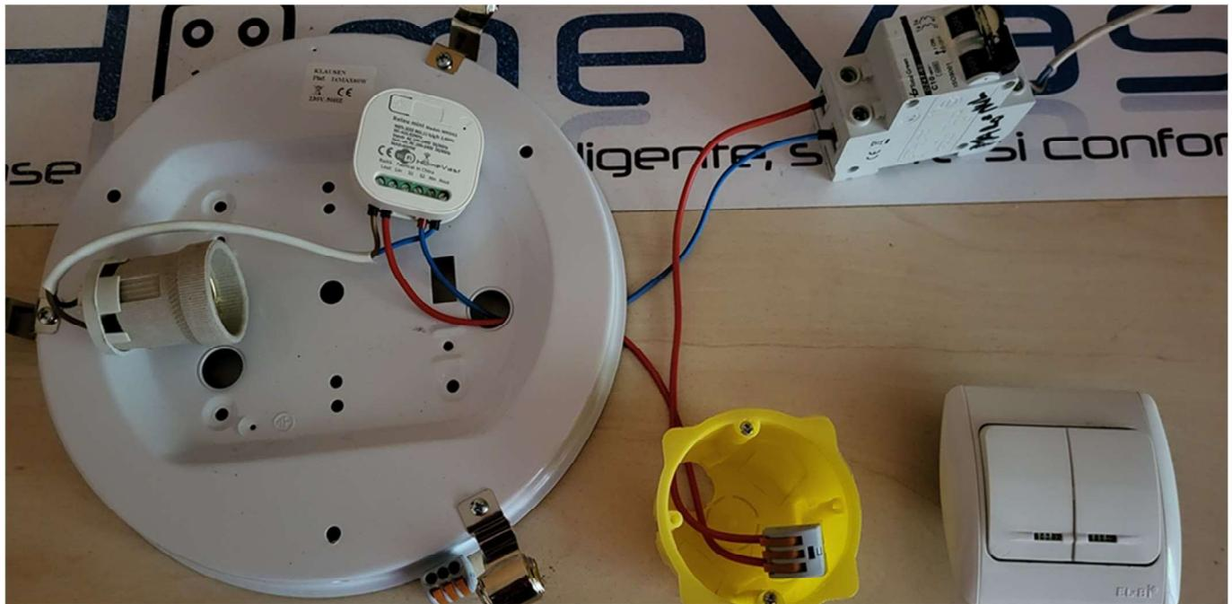
2. Se inlatura intrerupatorul existent si se conecteaza direct cablul de Faza si cablul de alimentare a becului. Ulterior, la fata dozei se va monta un intrerupator cinetic, ca in imaginea urmatoare.
